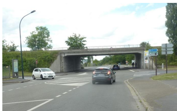
Passage sous RN184 / rue de Cergy
