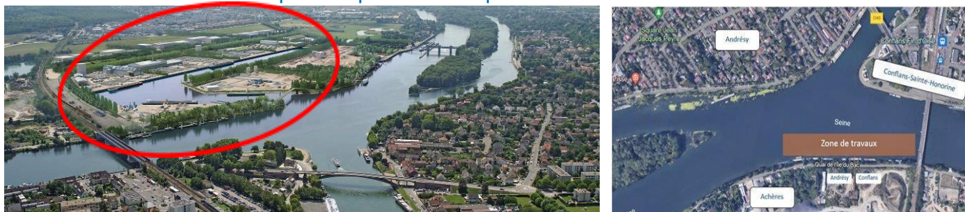
Vue du projet , zone des premiers travaux , et planning 2024
