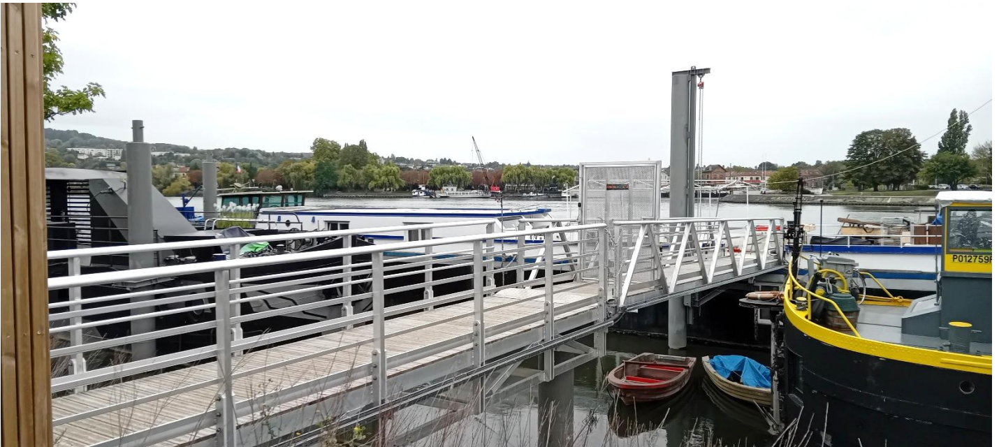
Travaux réalisés pour le déplacement des bateaux logements à l'entrée de la future darse
