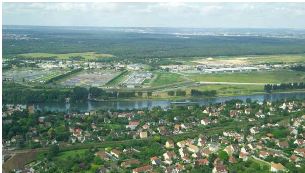
Vue aérienne de l'usine SIAAP-Seine-aval depuis Herblay-sur-Seine et La-Frette-sur-Seine (© Capui)
